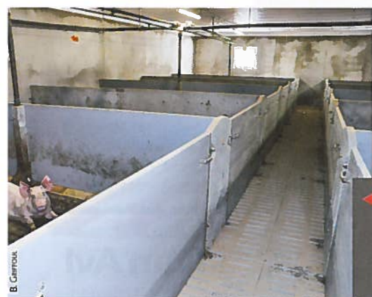
◀ LES SALLES DE L'ENGRAISSEMENT sont aménagées en 12 cases de 12 places. L'air entre par un plafond diffuseur. Il est extrait par une ventilation centralisée basse.
